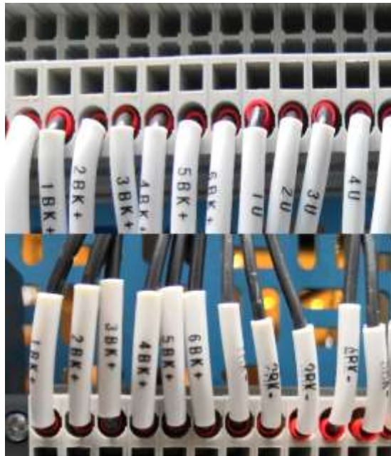
图 2-4 端子排接线
