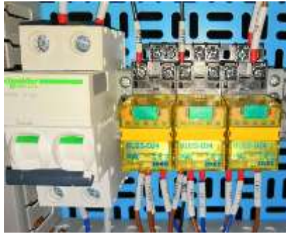
图 2-2 安全继电器安装效果参考图
